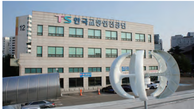
매연포집기 환기구에서 발생하는 풍력을 활용한 에너지 하베스팅 장치
